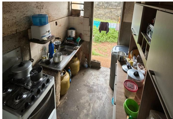
Cozinha Reparação nº 26 antes da reforma.
