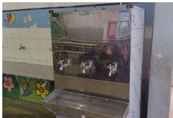
Bebedouro da CEMEI Joaquim Pires de Toledo instalado.
