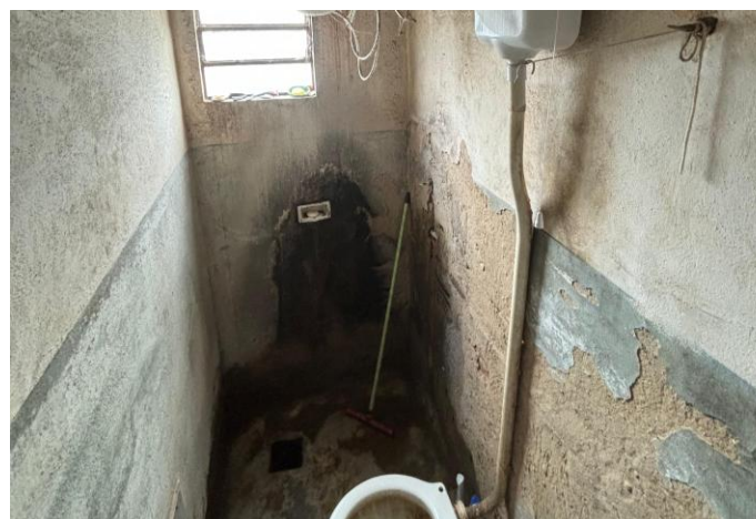
Banheiro Reparação nº 26 antes da reforma.
