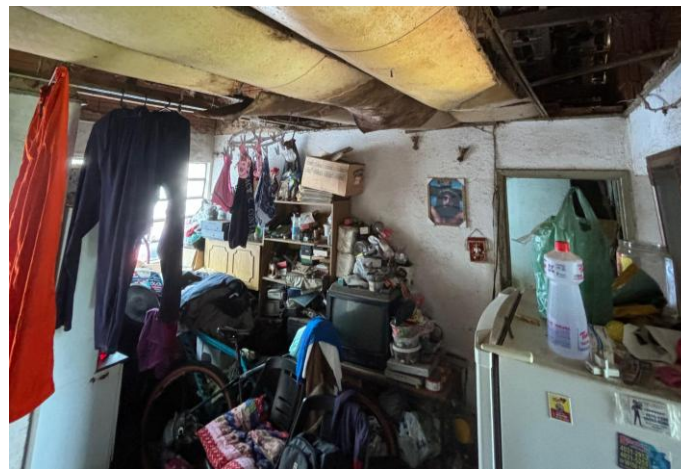
Sala da Reparação nº 26 antes da reforma.
