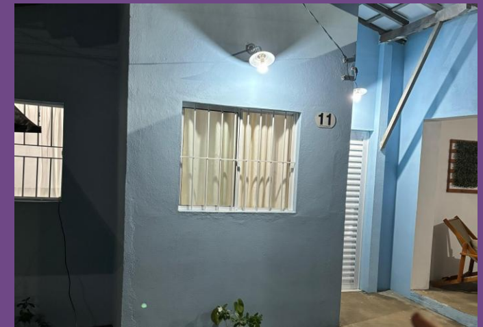
Reparação nº 26 após a reforma.
